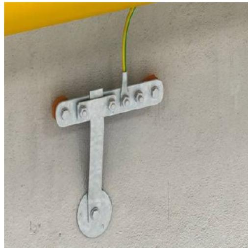
Fig. 10. Ligação equipotencial utilizando ATERINSERT [9].
